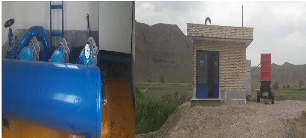
ایستگاه پمپاژ کلاته کاریز
